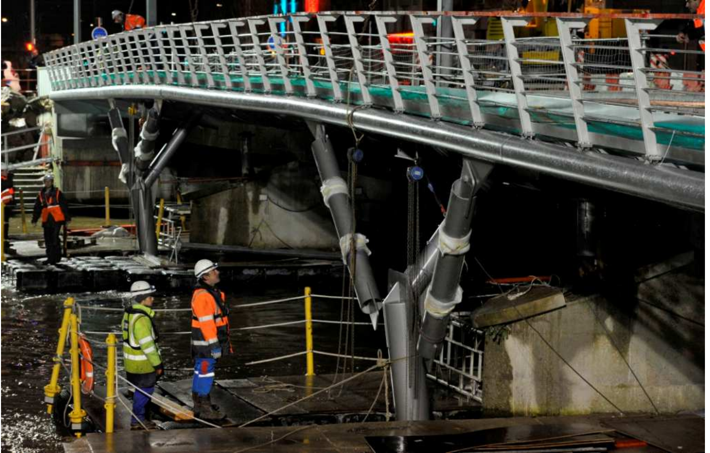
Vue de l'ouvrage en cours de travaux
