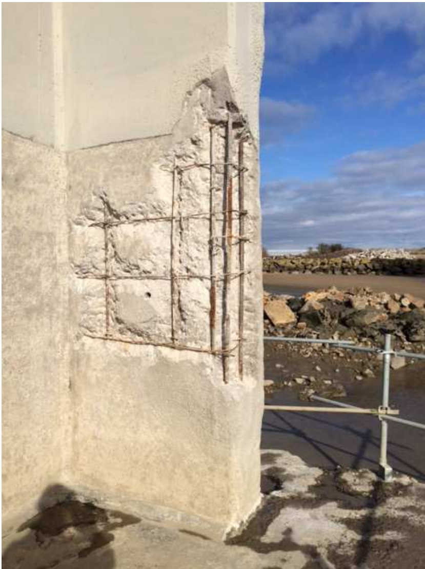
Exemple de zone dégagée avant réparations
